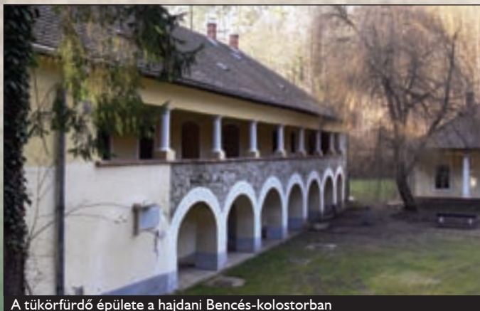
A tüskörfürdő épülete a hajdani Bencés-kolostorban
