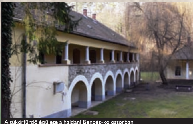
A tüskörfürdő épülete a hajdani Bencés-kolostorban
