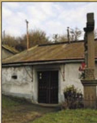
Ein Kellereingang in Kőporos
